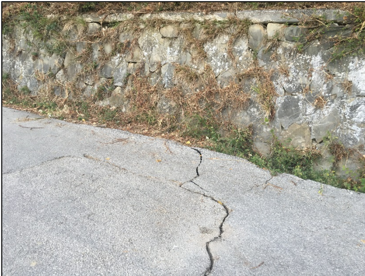
IS1_4. Fratture in prossimità del bivio subito fuori dell'abitato di Cossito.
