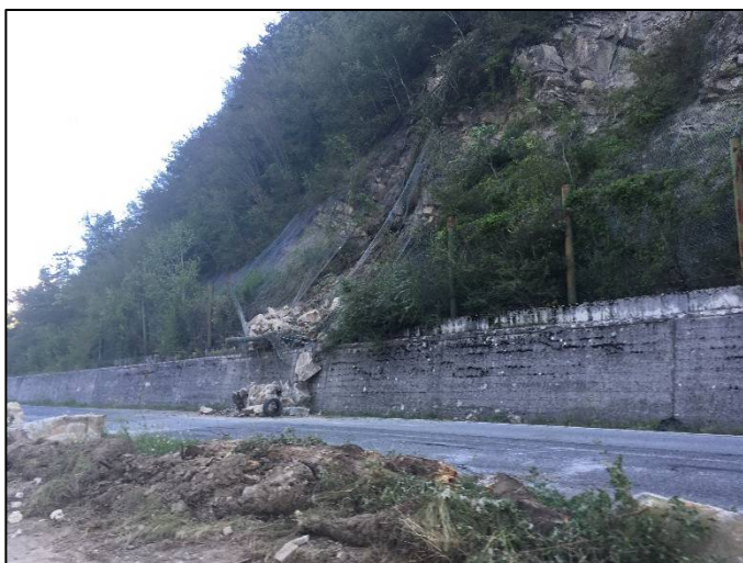
IS1_1. Crollo di blocchi arenacei lungo la strada che collega la SS Salaria ad Amatrice.
